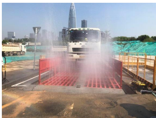
施工车辆冲洗
