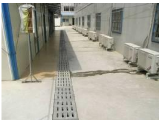
施工排水沟渠
