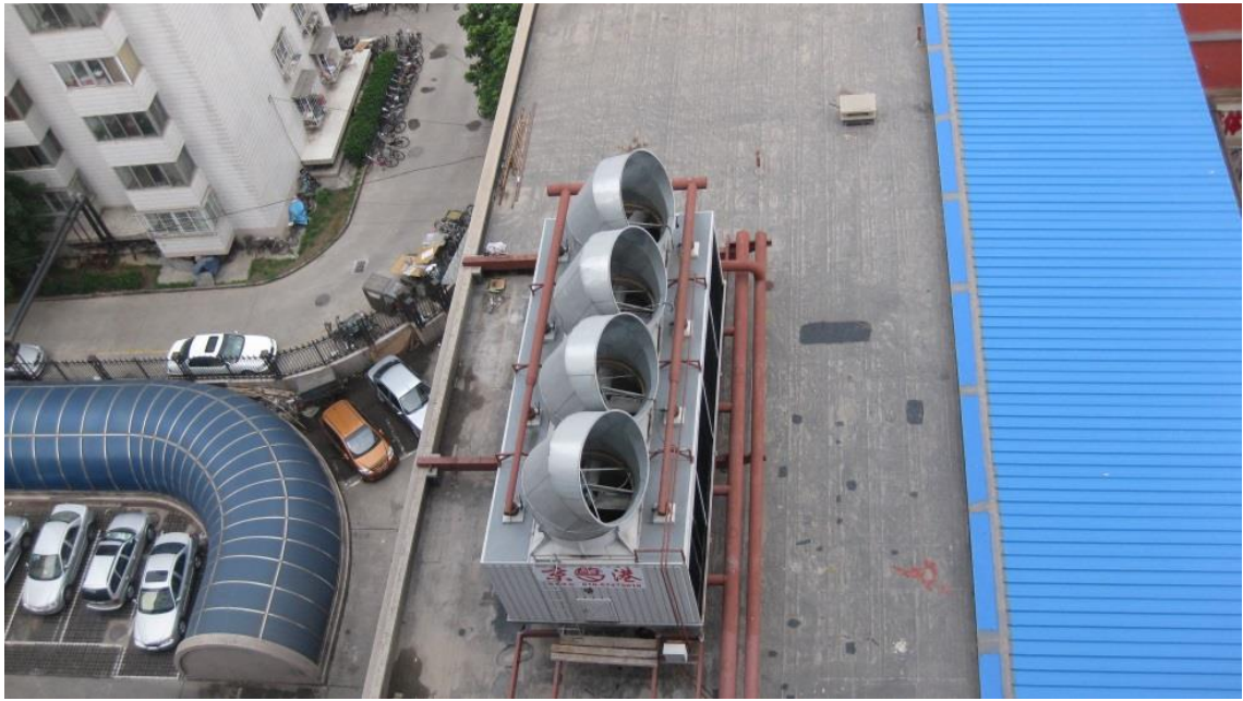
图 5.1-1 冷却塔安装导向消声器实施实例
