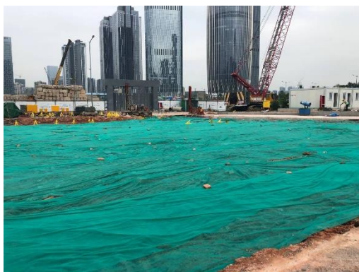
施工场地覆盖
