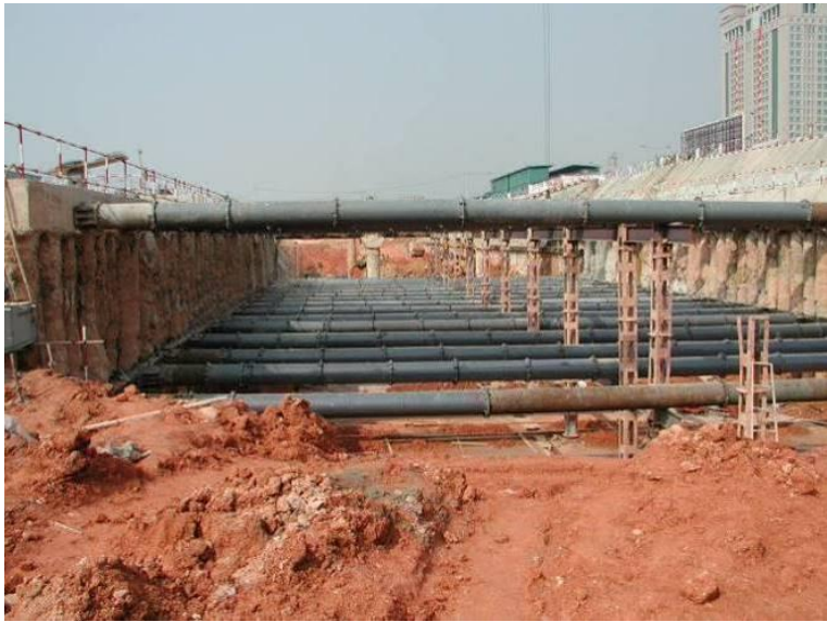
图 2.1-9 明挖法施工现场
