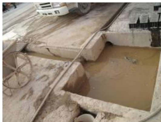
施工场地沉淀池
