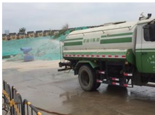
施工场地洒水
